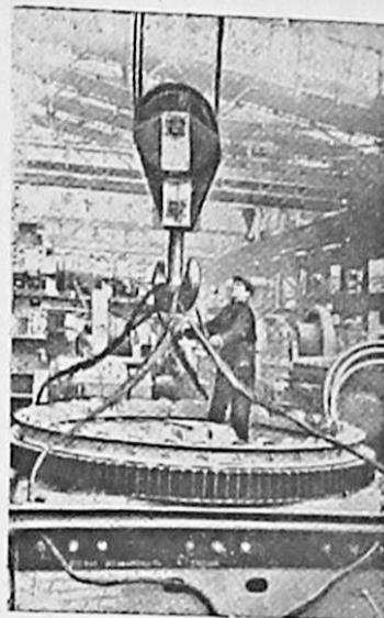
Свердловск. Недавно коллектив Уралмашзавода изготовил тысячу трехкубовый электрический экскаватор. На снимке: токалажник И. М. Масленников за демонтажем экскаватора «ЭСЗ-3».
